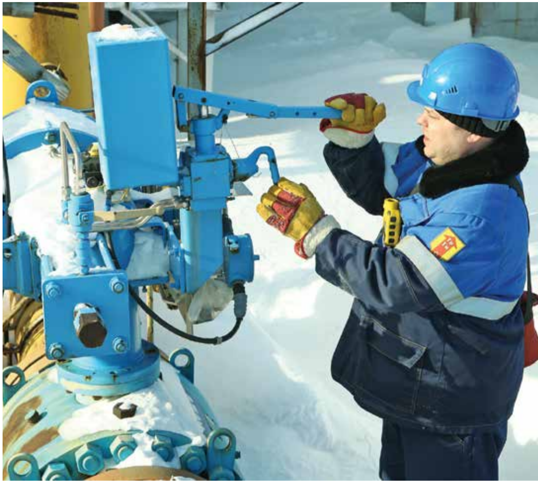
Оператор Андрей Черныш открывает задвижку на замерном узле
