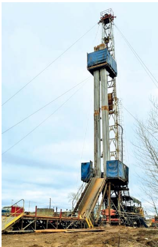
При ликвидации скважины используется специальное оборудование и подъемный агрегат
