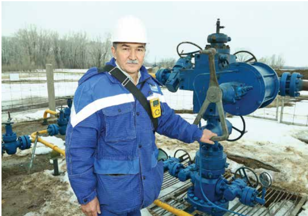
Шамиль Агишев ведет обслуживание скважины № 765-н
