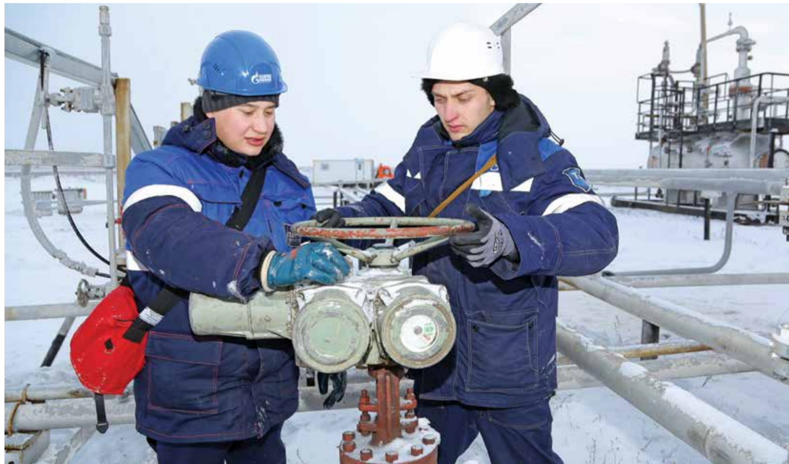
Операторы Максим Сесыко и Евгений Гладких проверяют работоспособность вновь установленной электроприводной задвижки газопровода скважины № 580-н
