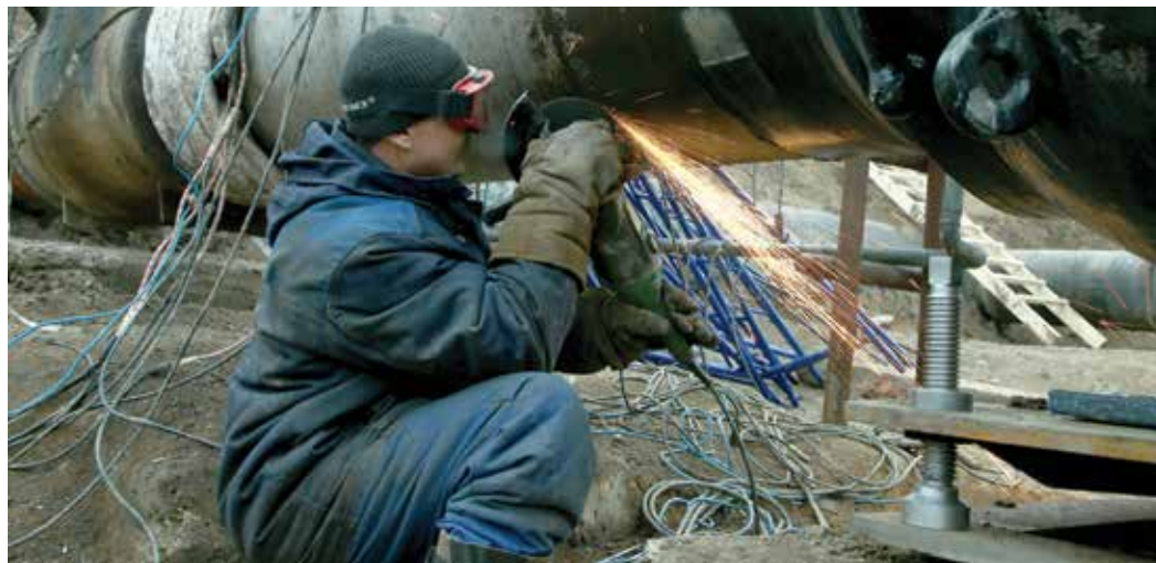
Ведется подготовка трубопровода к монтажу нового крана
