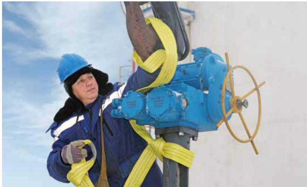
Оператор товарный Владимир Новиков производит монтаж запорной арматуры на новом технологическом трубопроводе
