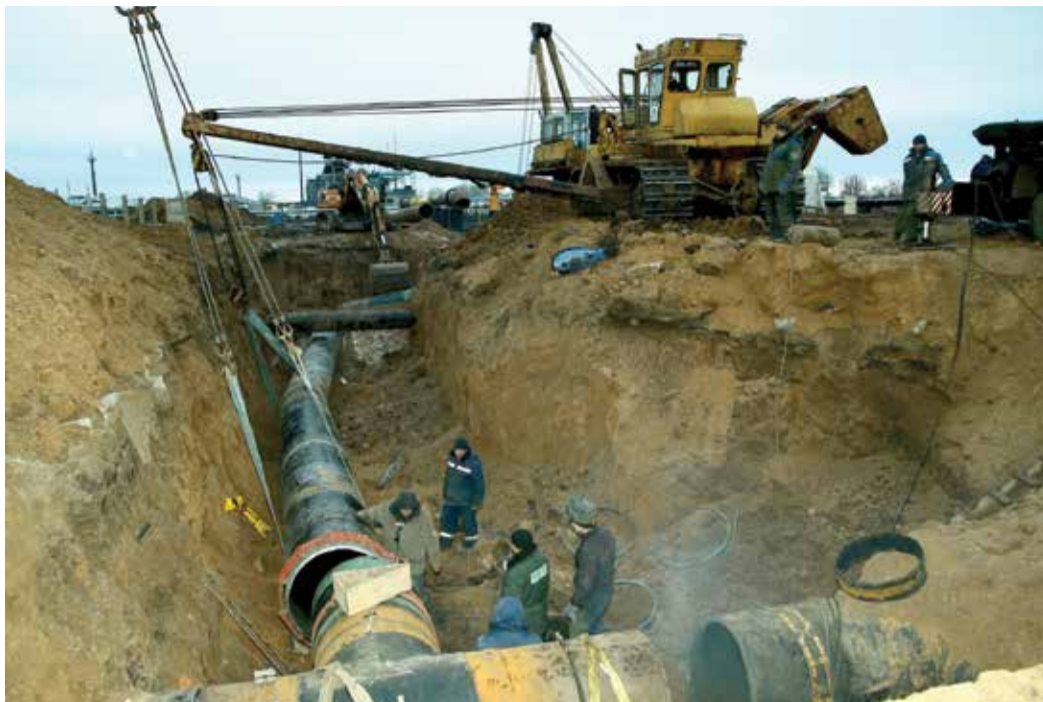
Ведется подключение газопровода-перемычки к дожимной компрессорной станции № 1
