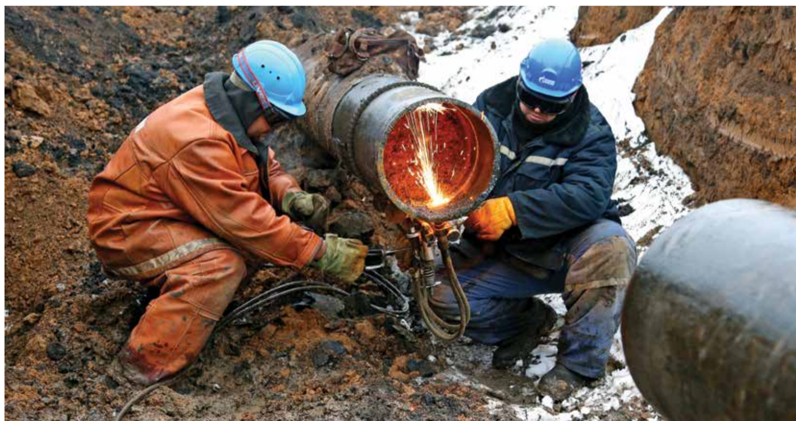
Идет монтаж перемычки между первой и второй нитками трассы Оренбург — Салават — Уфа
