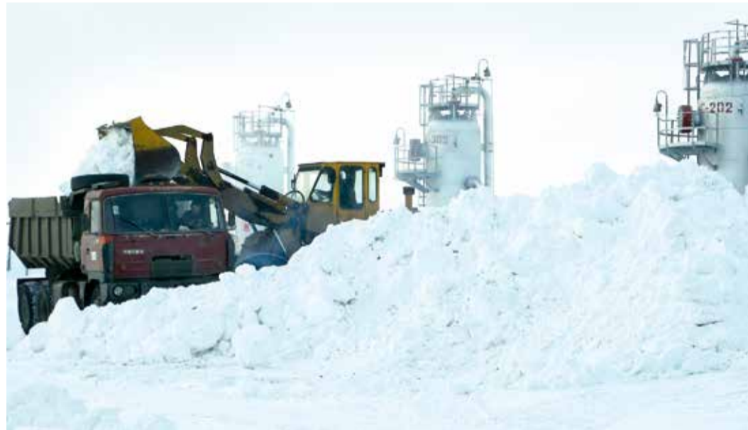
Ведется уборка снега (УКПГ-3)
