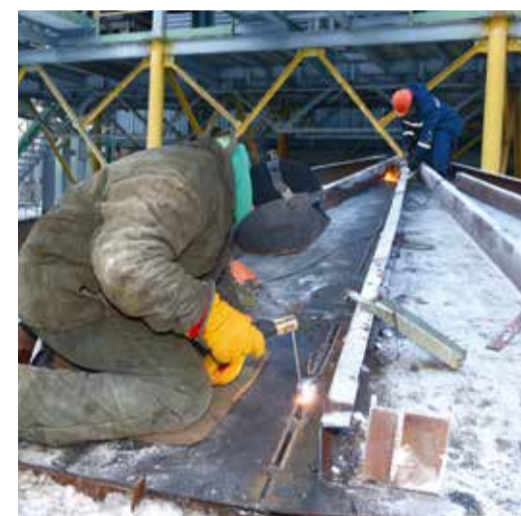
Этой крышей накроют цилиндр резервуара
