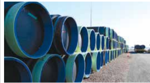
Трубы для первой из четырех ниток морского газопровода
