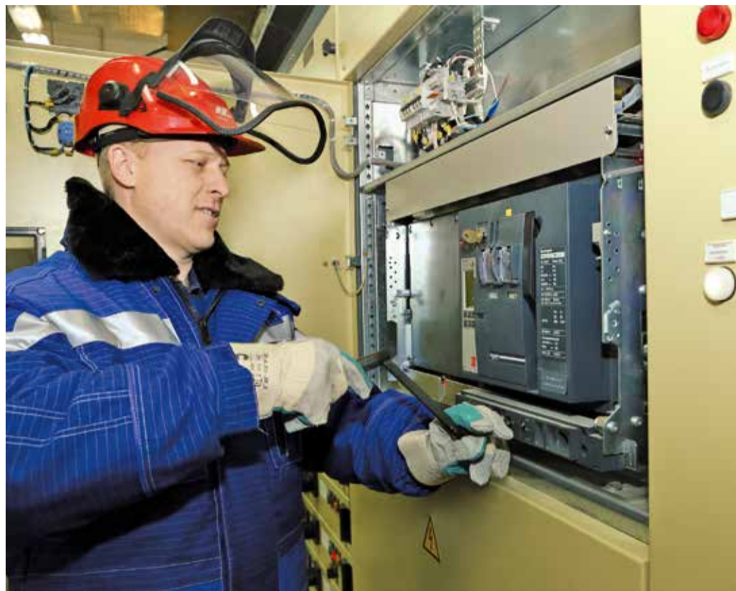
Комплекс мероприятий позволил заводу добиться существенной экономии электрической и тепловой энергии
