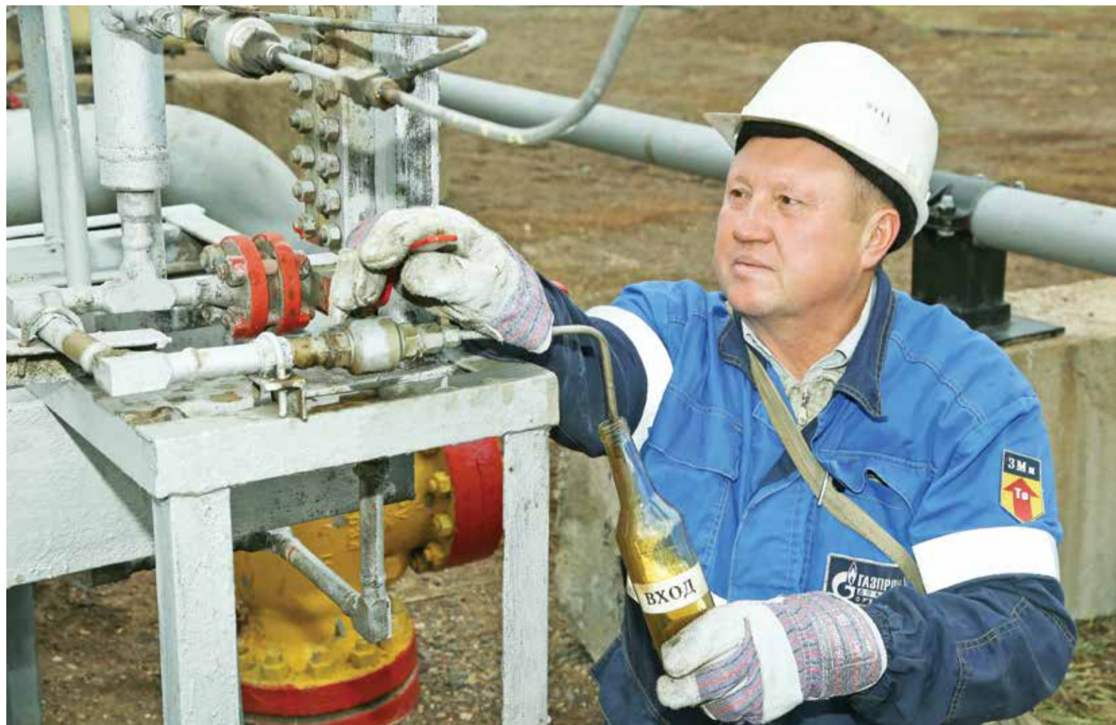
Машинист технологических насосов ДКС-1 ГПУ Сергей Балыкшов ведет отбор проб конденсата
