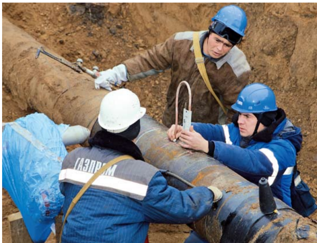
Работники участка обслуживания линейных трубопроводов измеряют уровень давления в конденсатопроводе
