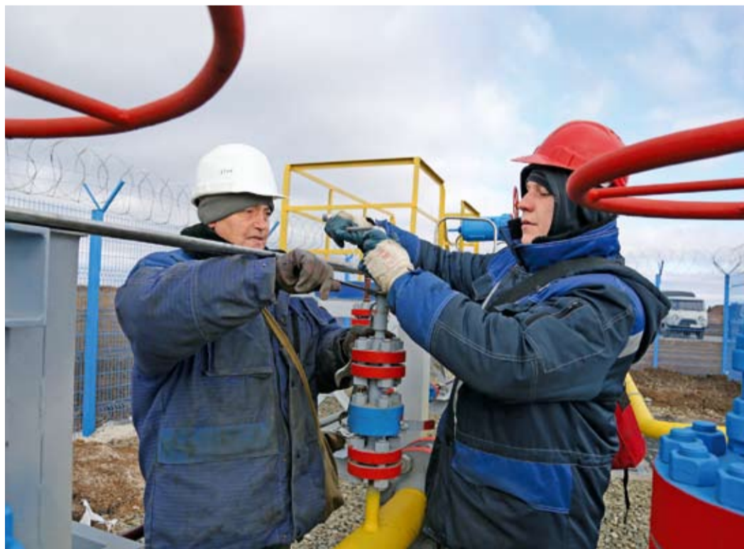
Операторы по добыче нефти и газа Рафик Хисматулин (слева) и Антон Чунихин выполняют протяжку штилек задвижки
