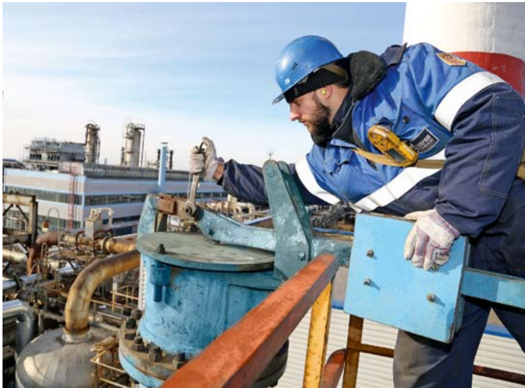
Оператор технологических установок Владимир Корчагин проверяет работоспособность клапана противовеса
