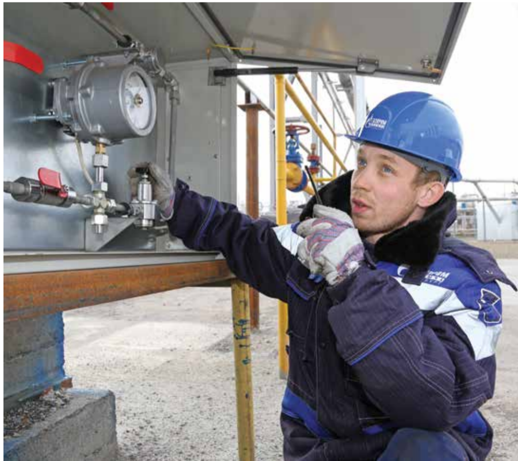
Оператор Андрей Карпов регулирует давление на дежурных горелках
