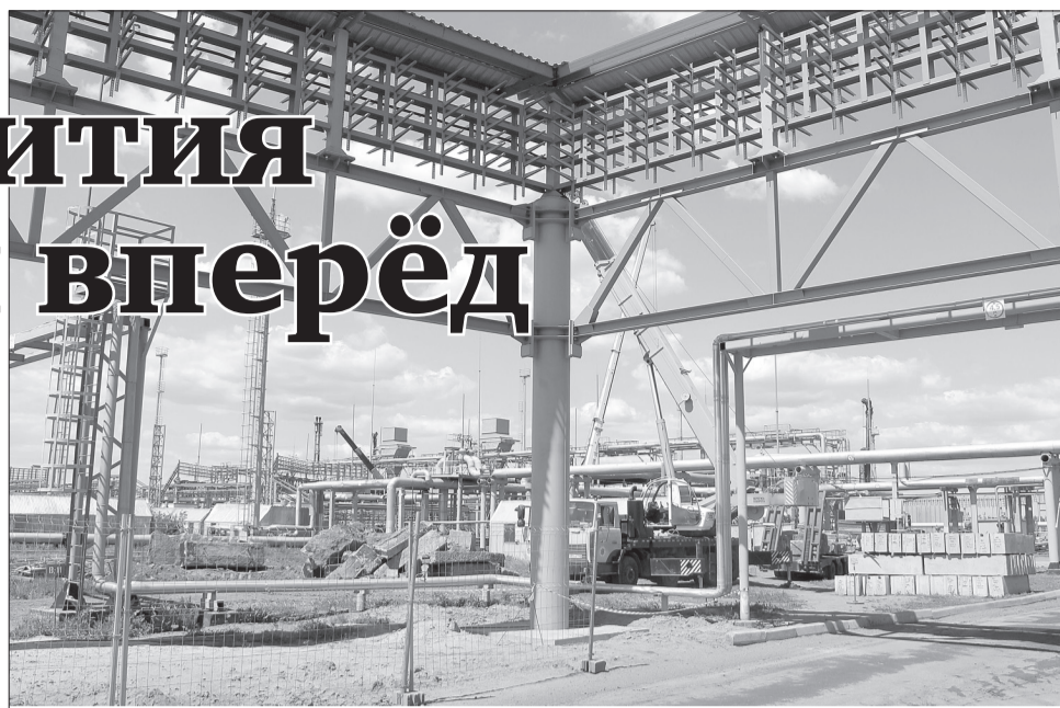
Реконструкция дожимных компрессорных станций идёт по плану
