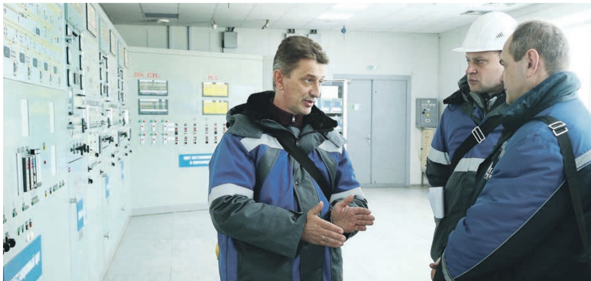
Генеральный директор ООО «Газпром добыча Оренбург» Олег Николаев в диспетчерской ДКС-2 беседует с заместителем директора газопромыслового управления по эксплуатации дожимных компрессорных станций Кириллом Михайленко и директором управления Сергеем Решетниковым.
