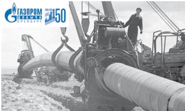
Строительство газопровода «Союз».
