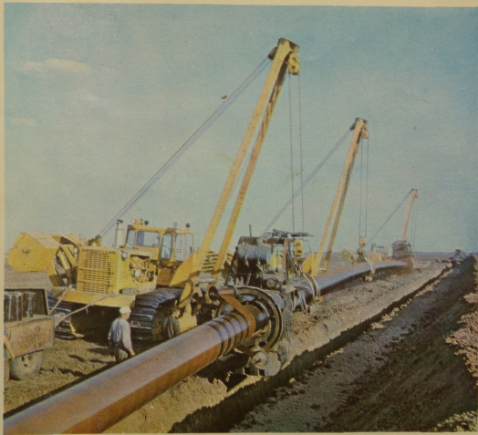
Последние метры газопровода.
