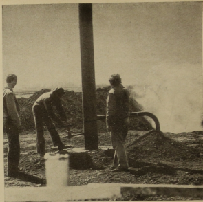
Испытание скважины.
