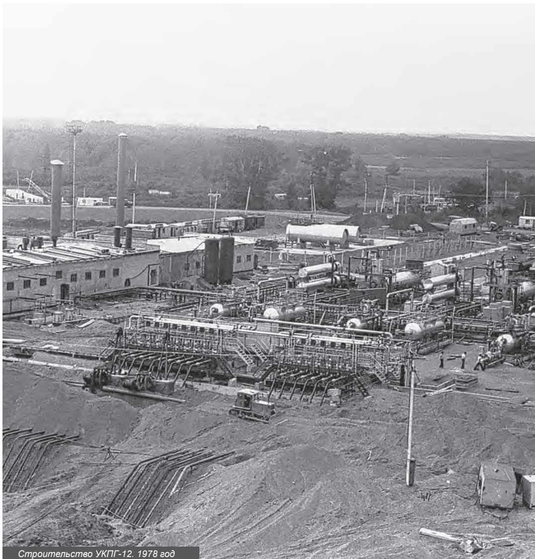
Строительство УКПГ-12. 1978 год
