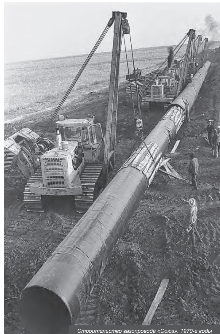
Строительство газопровода «Союз». 1970-е годы
