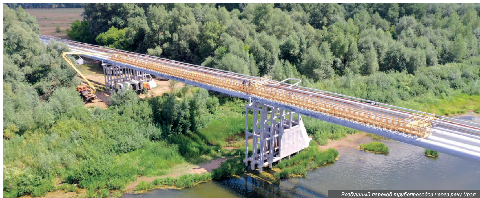
Воздушный переход трубопроводов через реку Урал
