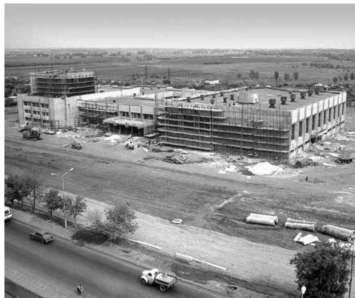
Строительство ДКиС «Дружба»
