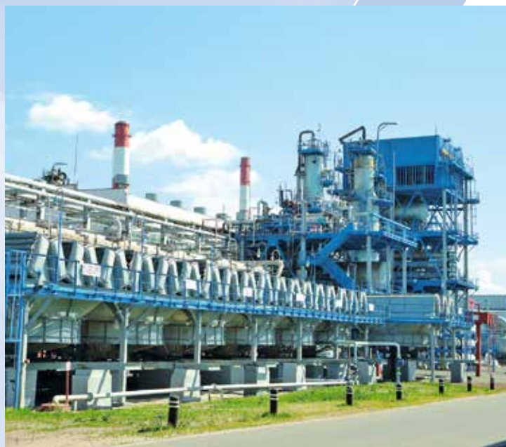
II очередь газоперерабатывающего завода
