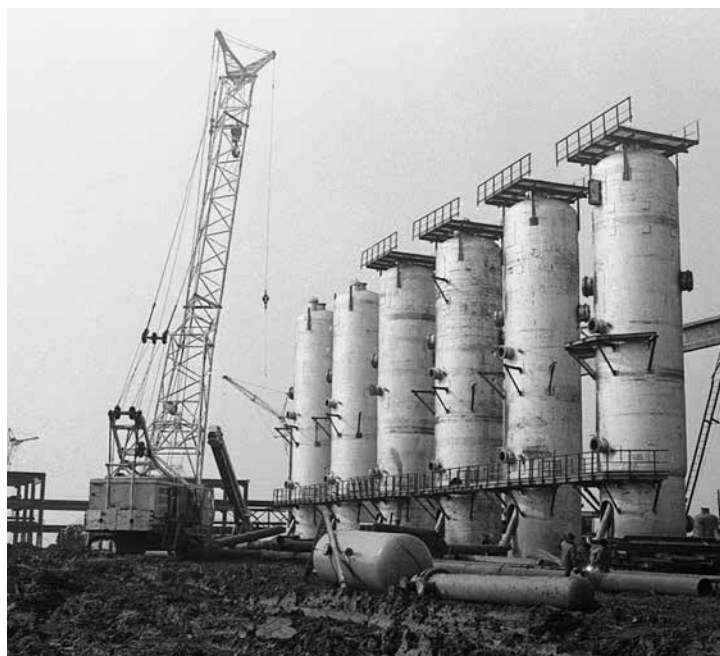
Строительство технологической установки №25
