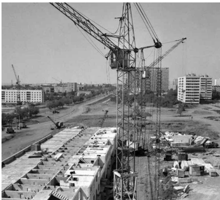
Строительство улицы Чкалова
