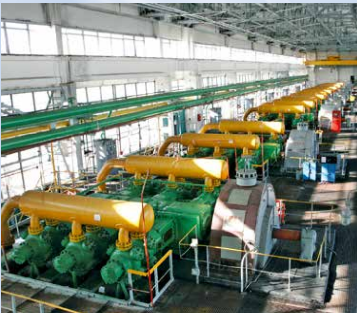
Компрессорный цех гелиевого завода
