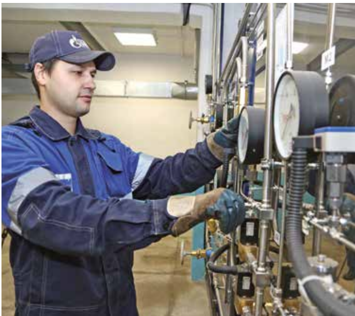
Регулировка пульта получения дыхательных кислородно-гелиевых смесей
