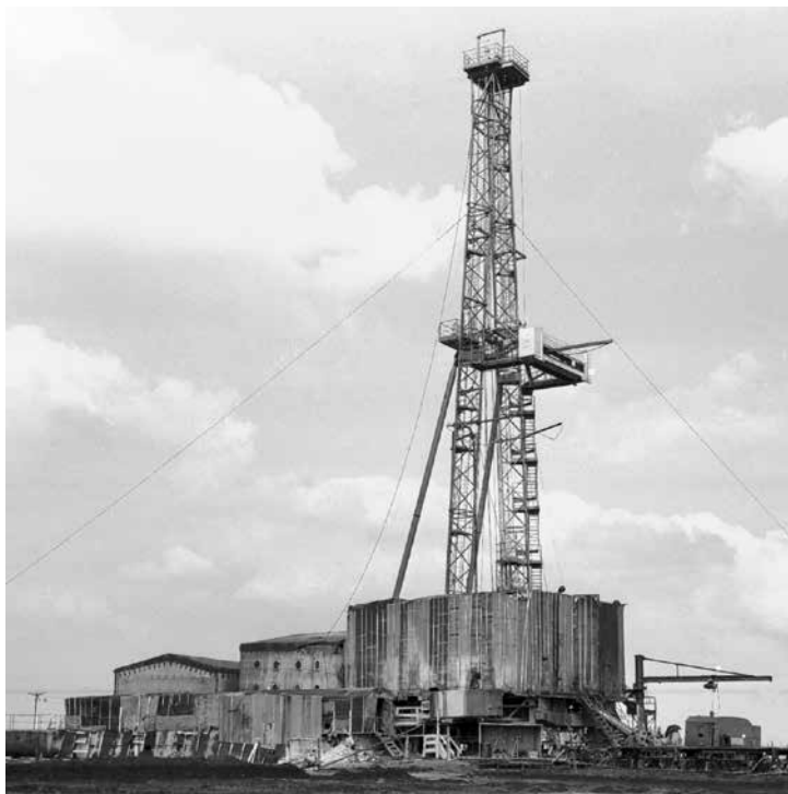
Буровой станок на Оренбургском нефтегазоконденсатном месторождении
