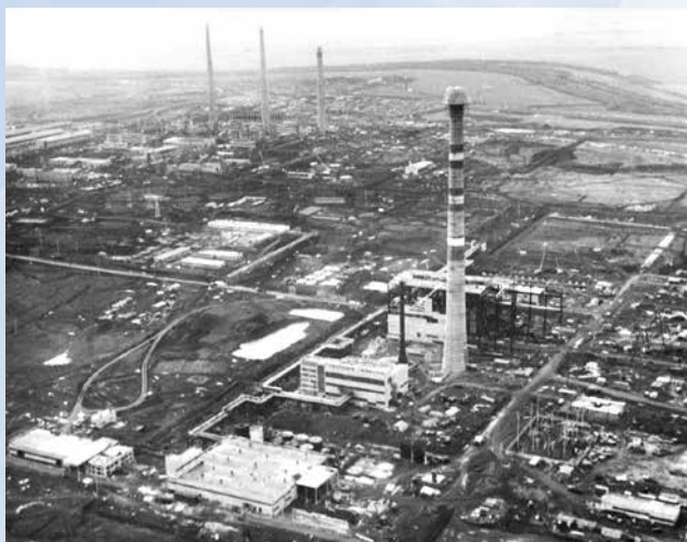
Строительная площадка I и II очередей газоперерабатывающего завода
