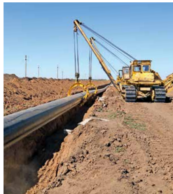
Строительство перемычки ДКС-1 – ДКС-2. 2015 год
