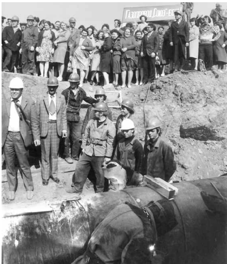
«Золотой» стык газопровода «Союз»
