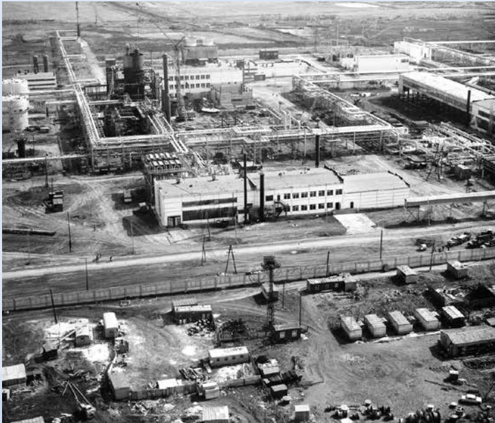
Панорама строительства гелиевого завода
