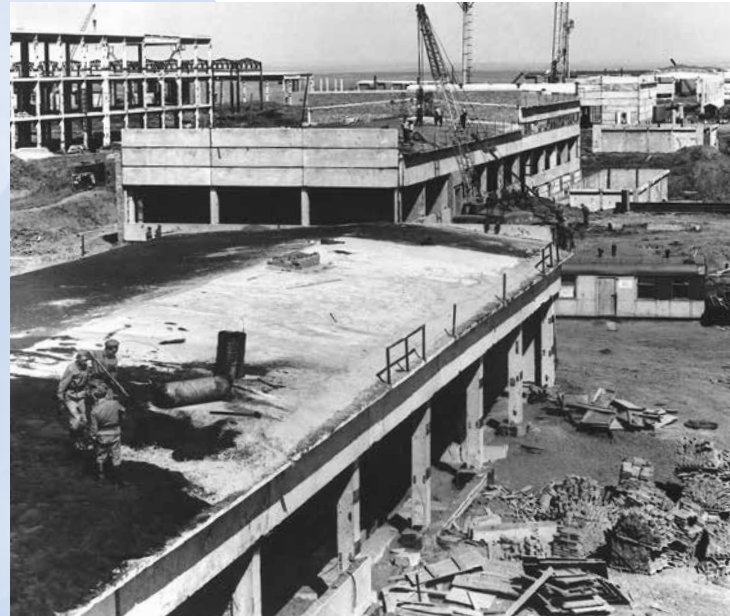
На строительной площадке гелиевого завода
