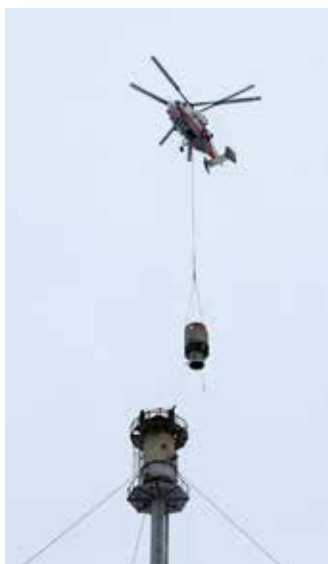
Монтаж оголовка факела на газоперерабатываю- щем заводе
