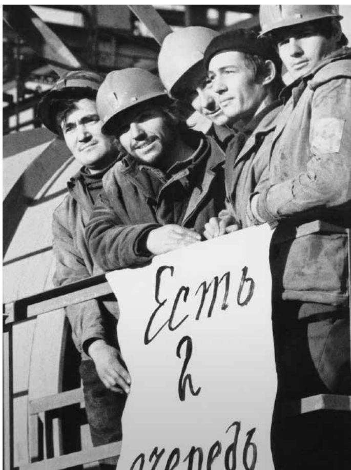
Пуск II очереди газоперерабатывающего завода
