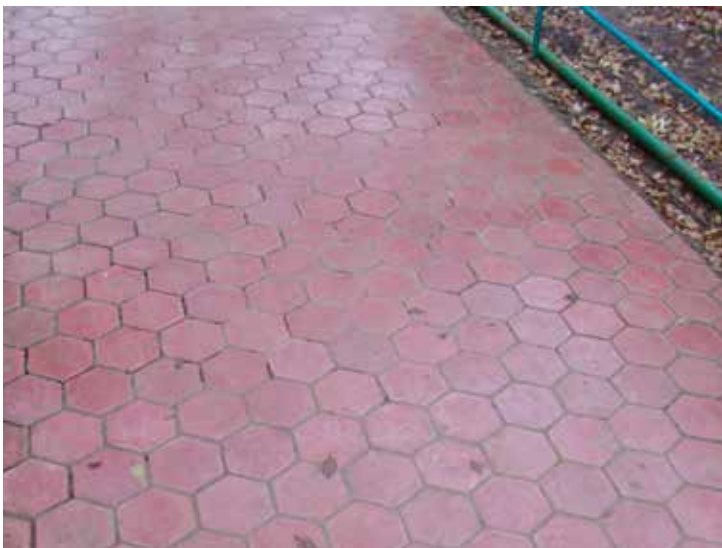
Тротуарная плитка с добавлением модифицированной серы
