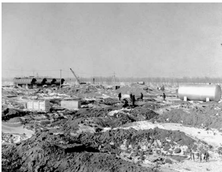
Начало строительства УКПГ-2
