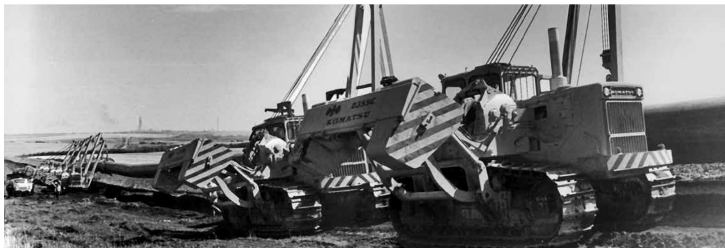
Строительство газопровода «Союз»
