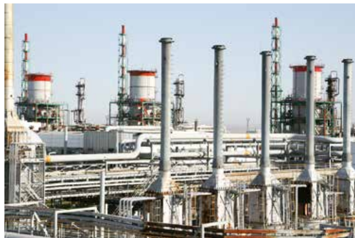
Печи подогрева гелиевого завода
