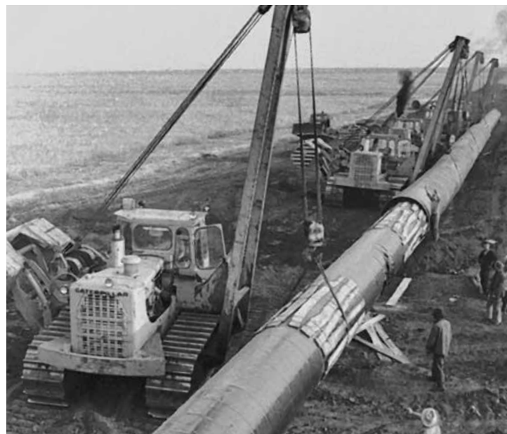
Газопровод «Союз». 1976 год
