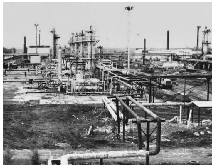
Строительство УКПГ-2. 1971 год
