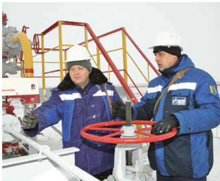
На многоствольной скважине УКПГ-10
