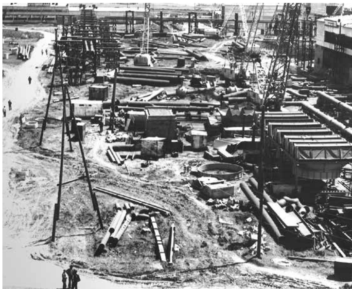
Начало строительства I очереди гелиевого завода
