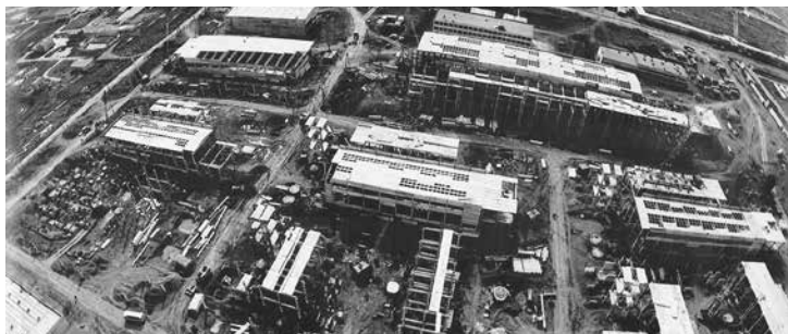
Панорама строительства III очереди газоперерабатывающего завода
