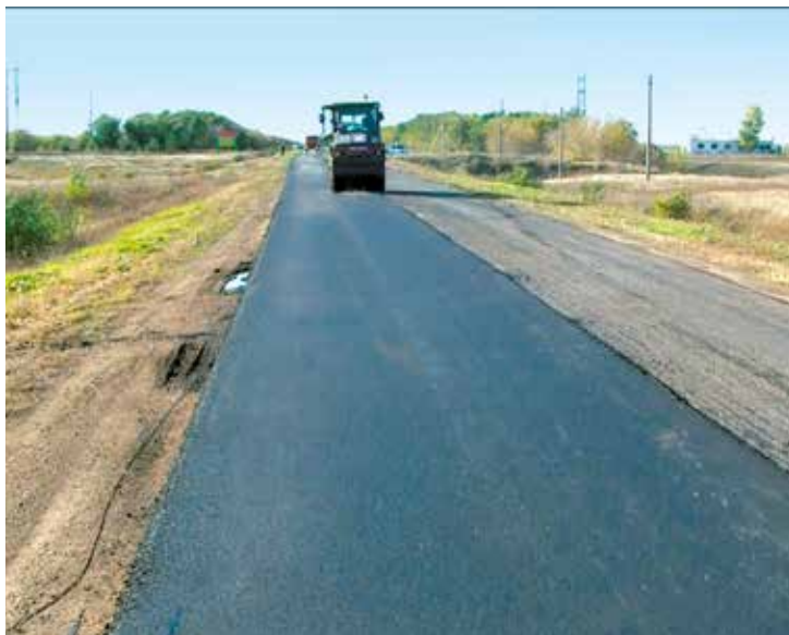
Укладка асфальта с добавлением модифицированной серы
