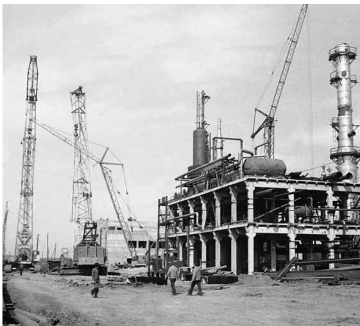
Строительство гелиевого блока №3
