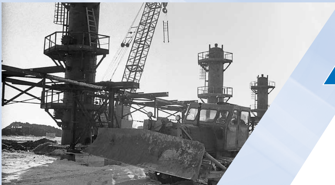
На строительной площадке УКПГ-2
