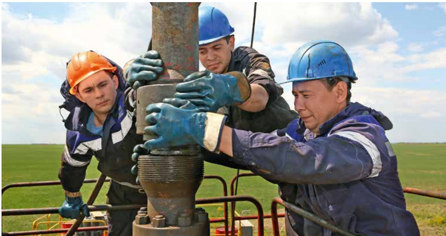
Монтаж лубрикатора ведут помощник бурильщика Сергей Бузанов, слесарь Евгений Просветов, помощник бурильщика Искандер Жалмухамбетов
