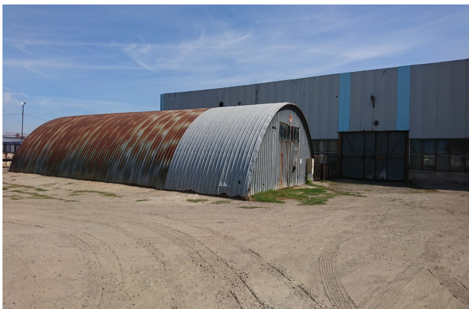
Инв. № 78*007000045 Одноэтажный склад типа Север литер С
