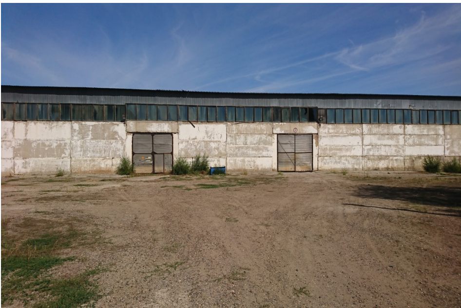
Инв. № 78*007000043 Одноэтажная стоянка крановой техники литер И
