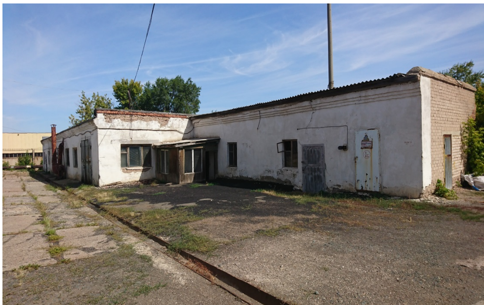
Инв. № 78*007000040 Двухэтажное здание профилактория обслуживания и ремонта спецтехники, литер Б
