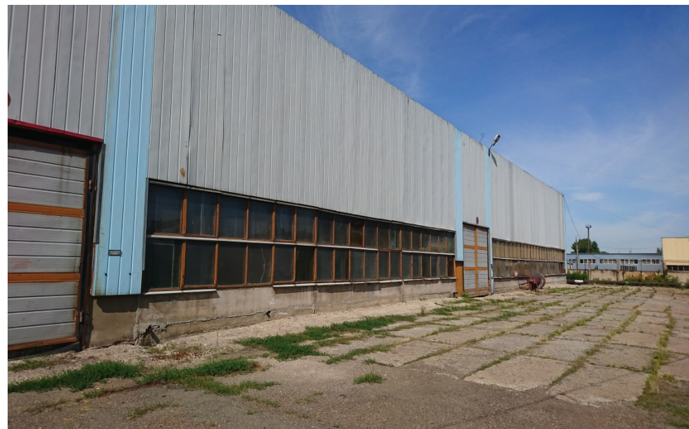
Инв. № 78*007000033 Одноэтажное здание механических мастерских, литер Р
