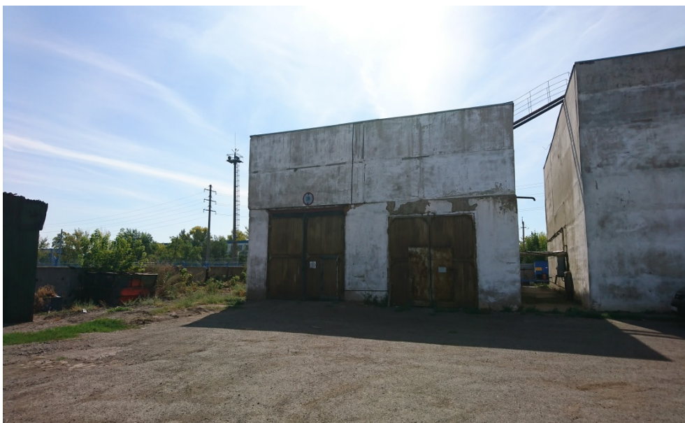
Инв. № 78*007000041 Двухэтажная мойка механизированная на 2 места литер М
