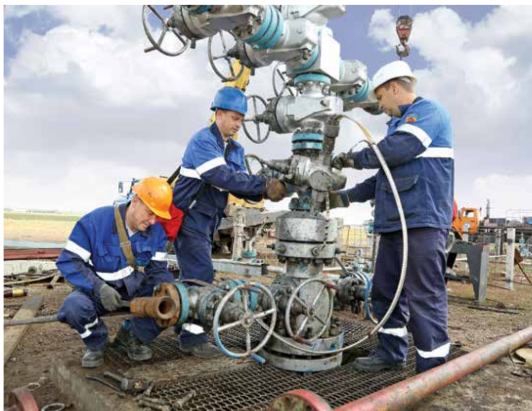
Операторы по добыче нефти и газа Виталий Колбасов (слева) и Александр Елюкин (в центре) и мастер Андрей Антипин ведут монтаж фонтанной арматуры и проверку управляемости задвижками перед пуском скважины в работу
