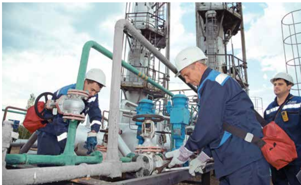
Бригада мастера Андрея Лукаша на ремонте технологического оборудования колонны регенерации метанола
