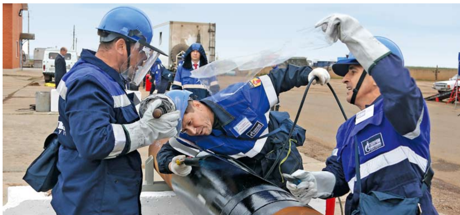
Работники Октябрьского ЛПУ (слева направо) Евгений Рыков, Сергей Кузьмин и Геннадий Чурсин выполняют практическое задание по изоляции трубопровода
