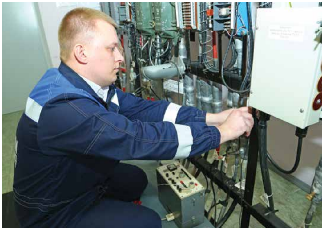
Старший электромеханик участка связи Олег Прилуцкий проверяет герметичность кабеля
