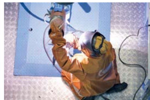
Выполняется практическое задание по сварке катушек
