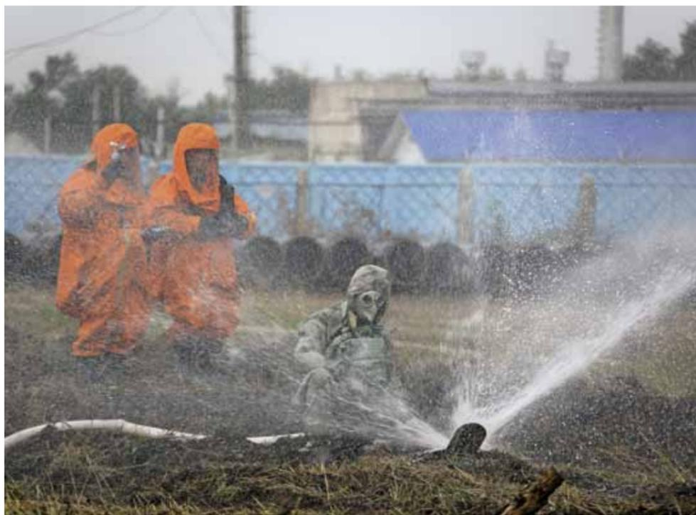
Ведется подготовка к постановке водяной завесы для предотвращения распространения паров метанола
