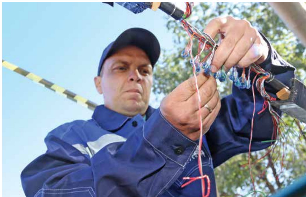
Старший электромеханик Дмитрий Зотов выполняет монтаж муфты телефонного кабеля
