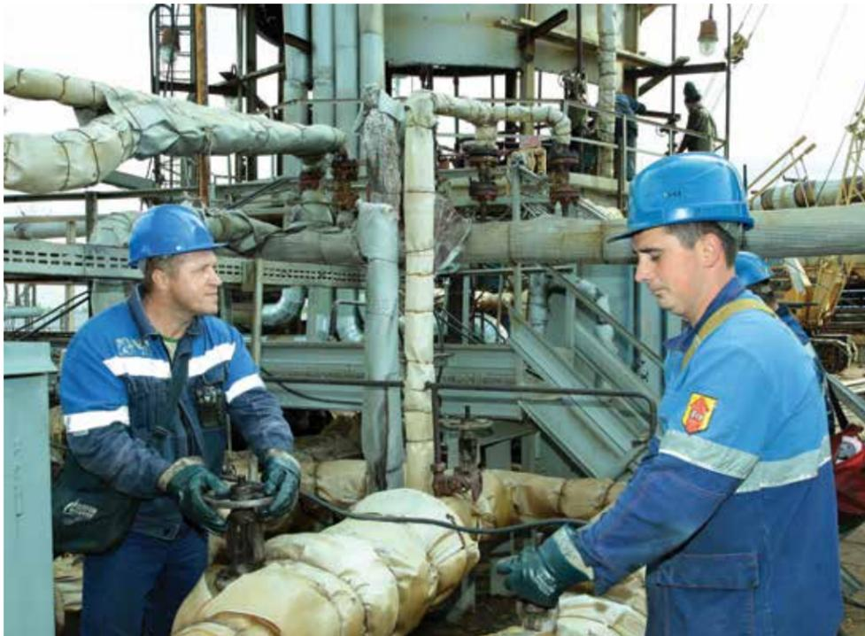
Операторы технологической установки У-730 Евгений Балыкин (слева) и Виталий Гареев проводят ревизию запорно-регулирующей арматуры
