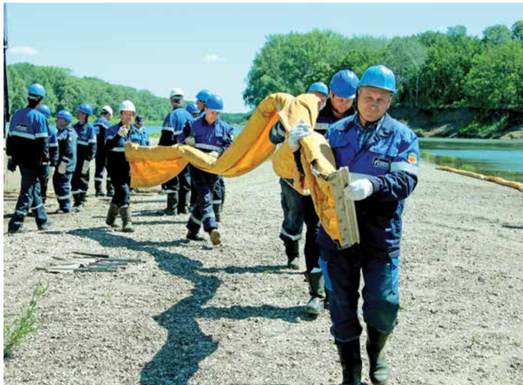
Бон — легкое плавучее заграждение. Но, чтобы установить его, нужны усилия целой команды
