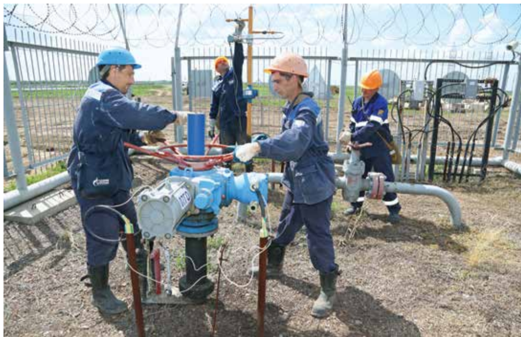
Бригада под руководством Николая Романова переключает запорную арматуру для остановки газопровода
