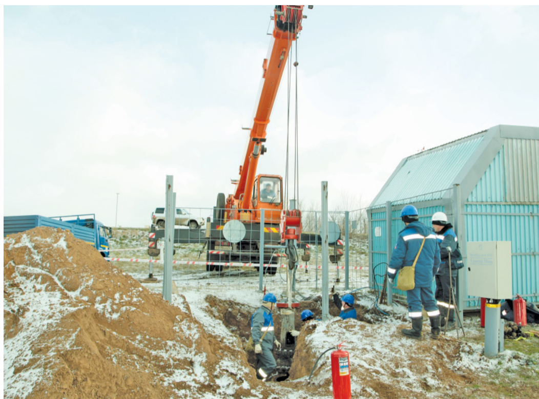
Работники Октябрьского ЛПУ демонтируют крышечный комплект запорной арматуры
