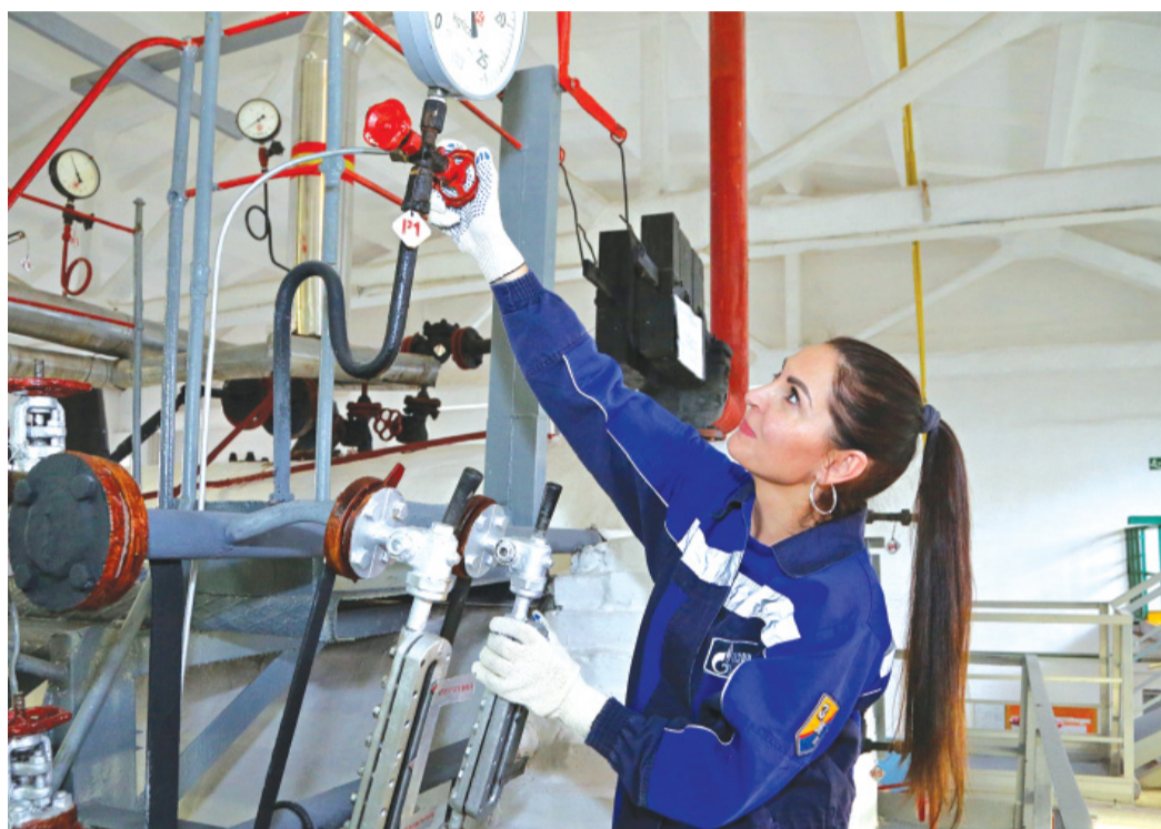
Алена Шило проверяет правильность показаний котлового манометра
