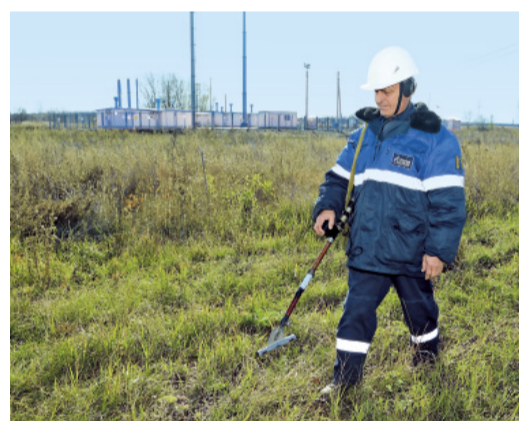
Старший электромеханик связи Михаил Пятунин ищет место прохождения кабеля под землей
