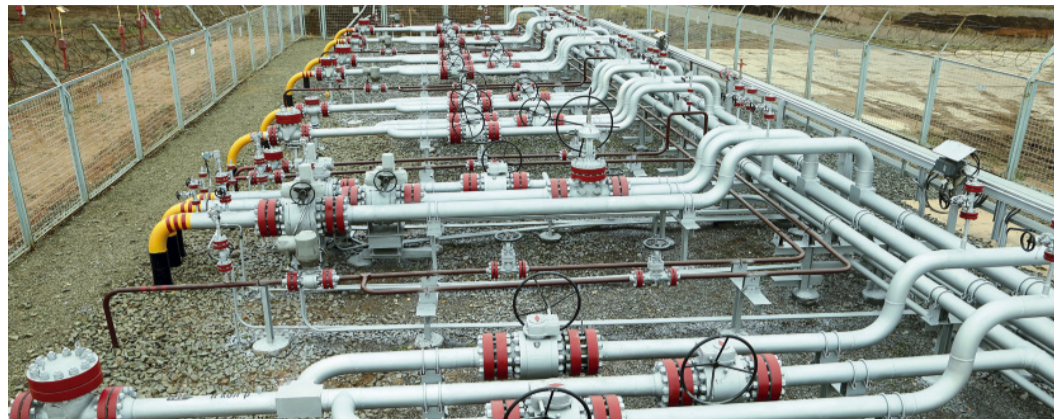
Трубопровод для транспортировки жидких углеводородов будет подключен к сборно-распределительной гребенке № 8
