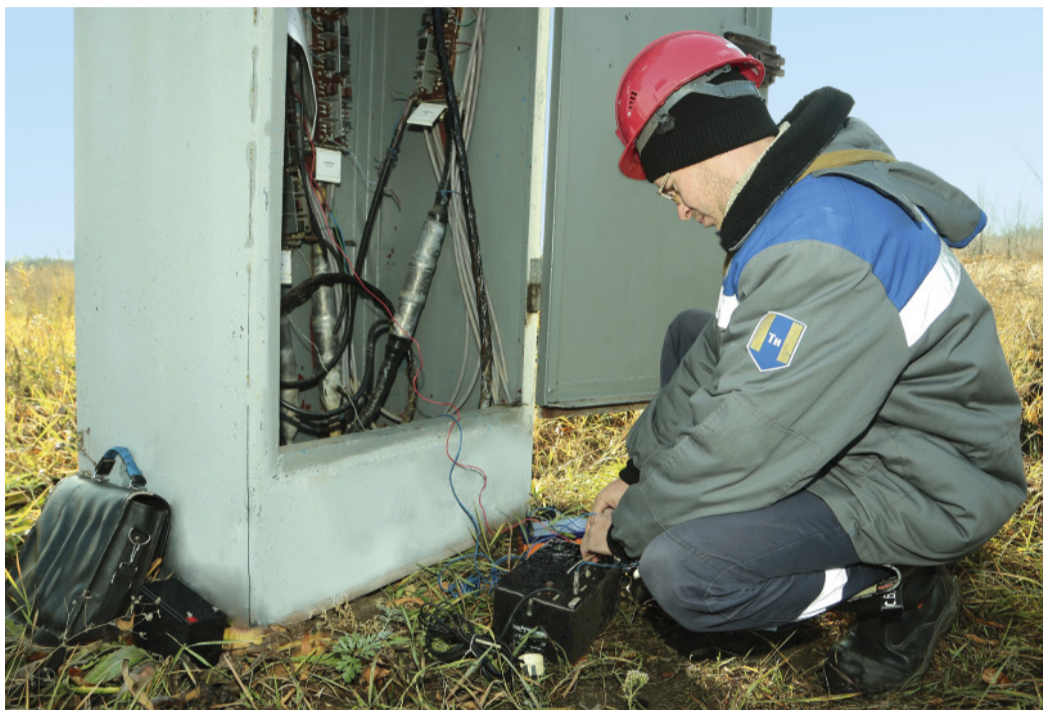
Электромонтер линейных сооружений связи Виталий Суханов проводит подключение генератора для подачи сигнала в кабельную линию
