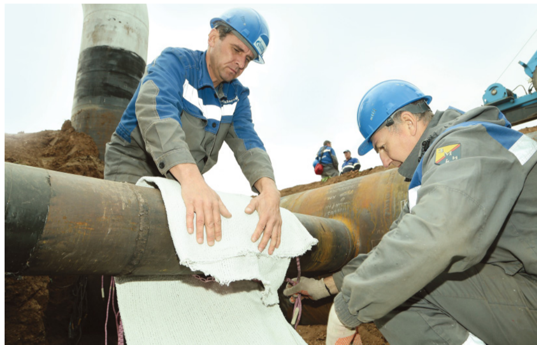
Термисты Андрей Тузиков и Дмитрий Виттор готовят сварное соединение к термообработке
