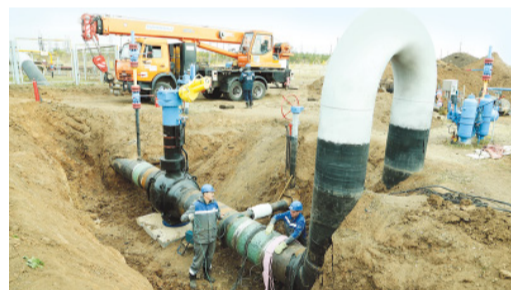
Завершаются работы по замене кранового узла на трубопроводе неочищенного газа
