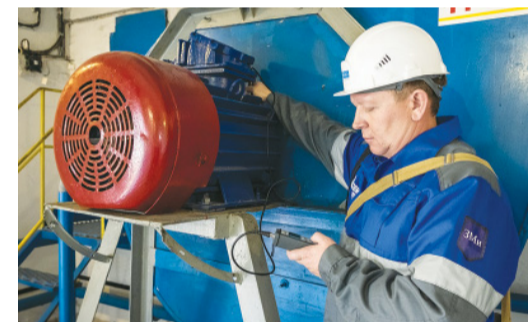
Сергей Краснов проводит вибрационный контроль вентиляционного оборудования
