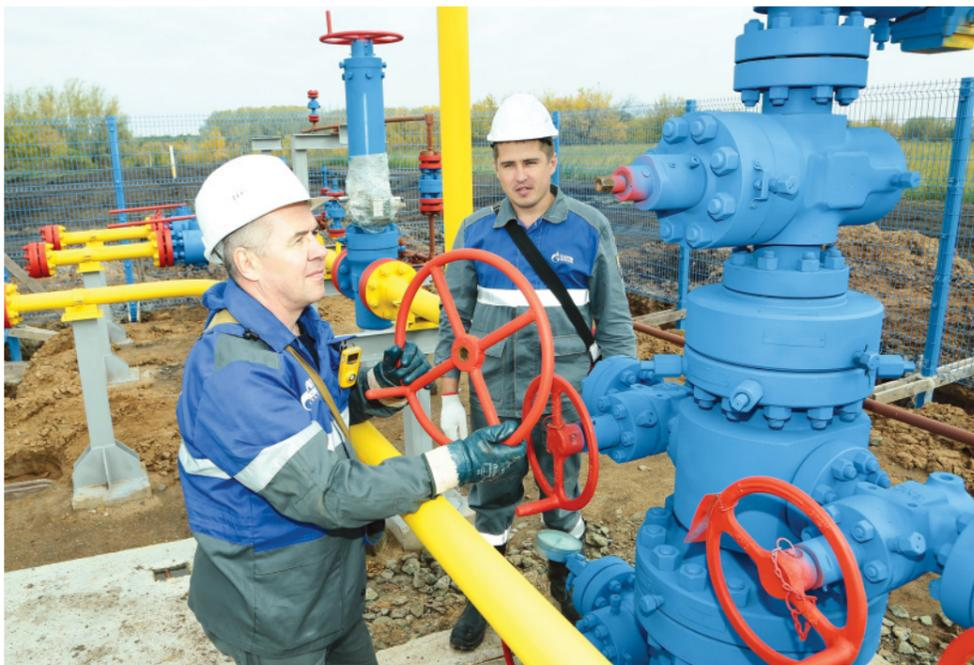
Оператор по добыче нефти, газа и конденсата Станислав Ноев и геолог Алексей Болтенков восстанавливают управление фонтанной арматурой на скважине после нанесения антикоррозионного покрытия
