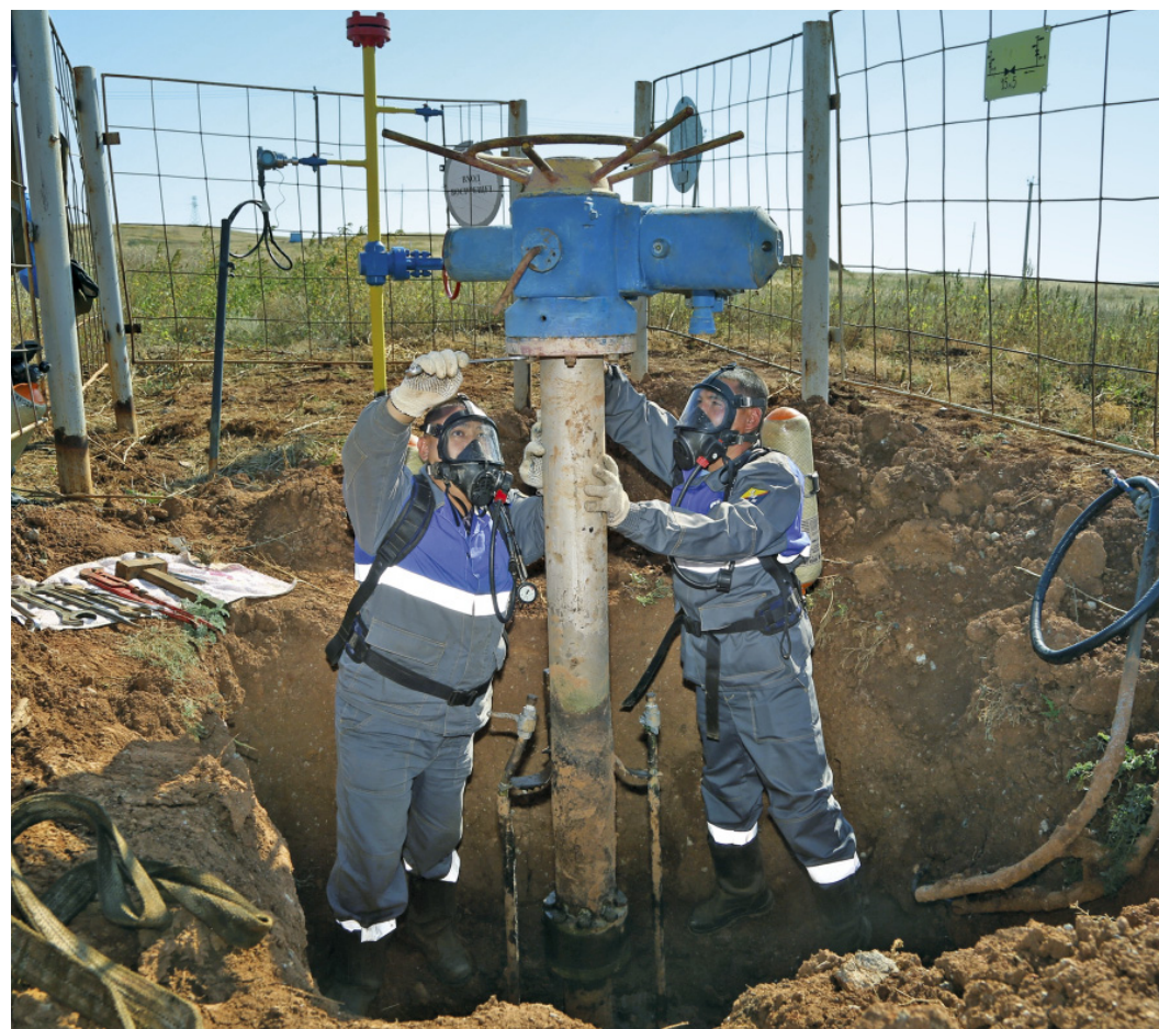
Тимур Гайсин и Алексей Карякин выполняют газоопасную работу по ремонту запорной арматуры
