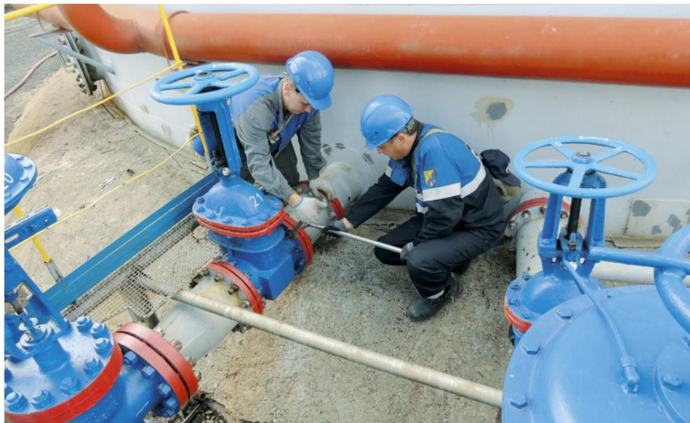
Вячеслав Прохоров и Антон Стец герметизируют фланцевые соединения
