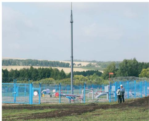
Узлы запуска-приема очистных диагностических устройств на 136-м километре продуктопровода Оренбург — Салават — Уфа Октябрьского ЛПУ УЭСП
