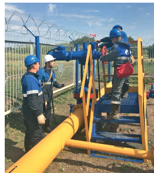
Работники Абдулинского ЛПУ проводят комплексное опробование запорной арматуры
