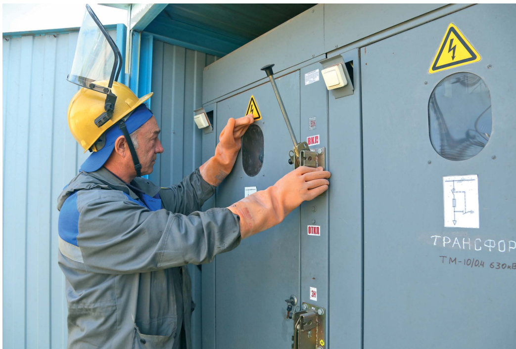
Электромонтер Михаил Процанов производит осмотр силового электрооборудования
