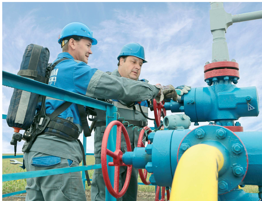
Сергей Щипанов и Игорь Приходков демонтируют крышечный комплект буферной задвижки на скважине
