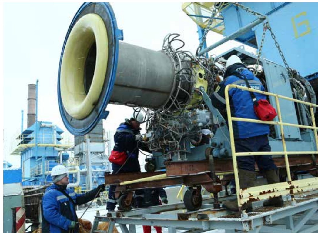
Газотурбинный двигатель устанавливается в блок-боксе газоперекачивающего агрегата № 6
