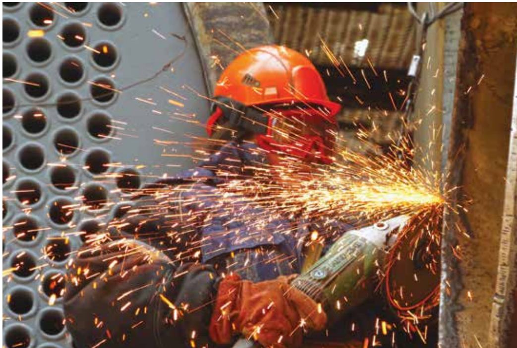
На монтируемом котле ведется зачистка трубы под сварное соединение
