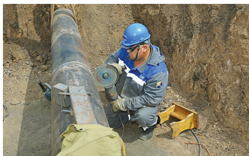
Зачистка сварных швов — обязательная процедура
