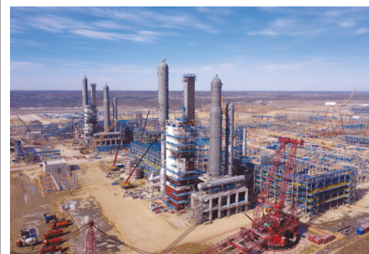
Строительная площадка Амурского ГПЗ
