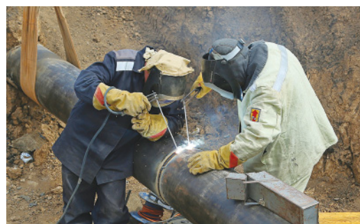
Сварщики УАВР монтируют катушку
