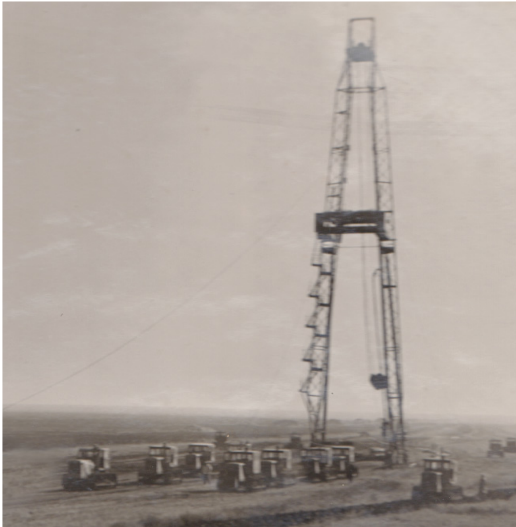
Марш буровой установки на новую точку
