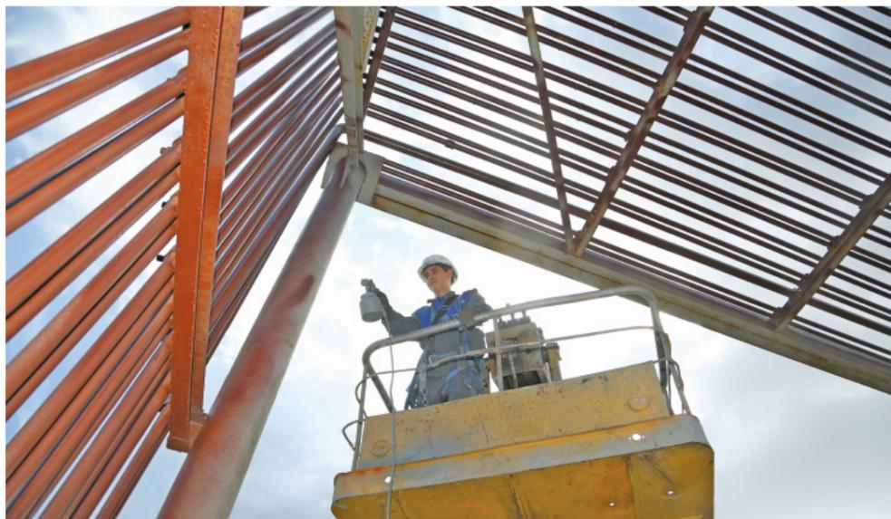
Оператор по добыче нефти и газа Руслан Яббаров наносит антикоррозионное покрытие
