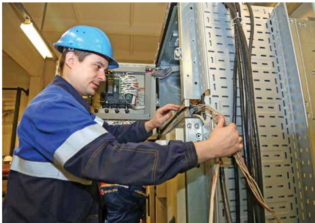
Электромонтер Антон Ротт подключает контрольный кабель цепи защиты компрессора
