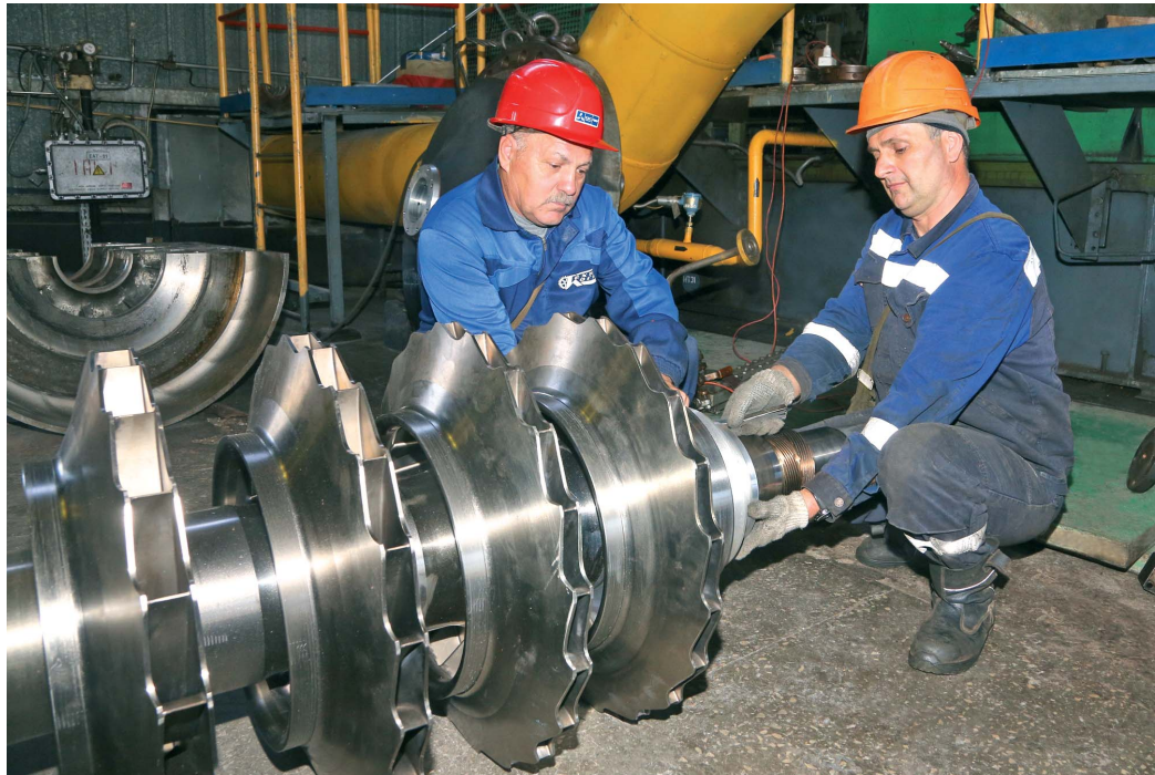
Ведется подготовка к монтажу ротора центробежного нагнетателя
