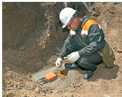
Для проведения акустико-эмиссионного контроля на трубопровод крепится датчик, который позволяет выявлять даже скрытые дефекты металла
