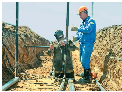
Ведутся сварочно-монтажные работы по подключению внутрипромысловых трубопроводов
