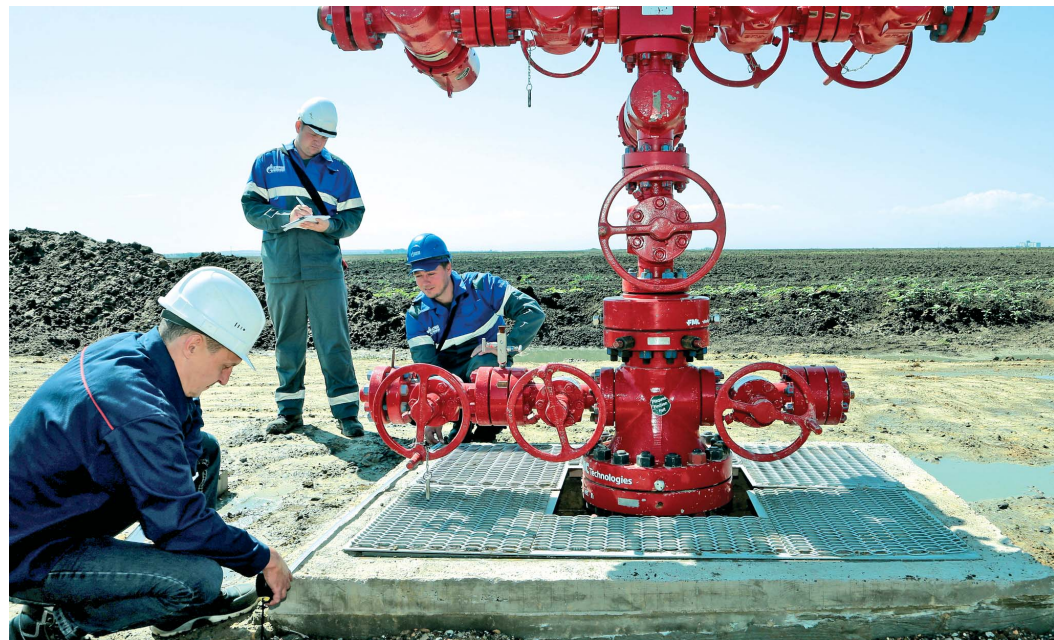
Газодобытчики Павел Чиндяев, Александр Пирогов (на втором плане) вместе с представителем подрядной организации Артемом Долматовым проводят контрольный замер фундамента шахтного колодца скважины
