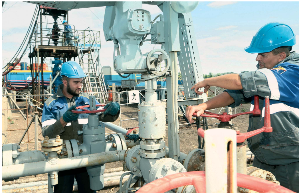
Выполняется пуск скважины через блочную мобильную сепарационную установку
