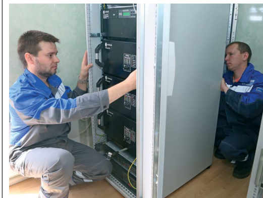
Дмитрий Селезнев и Владимир Бояркин устанавливают батареи для бесперебойного питания усилительной аппаратуры
