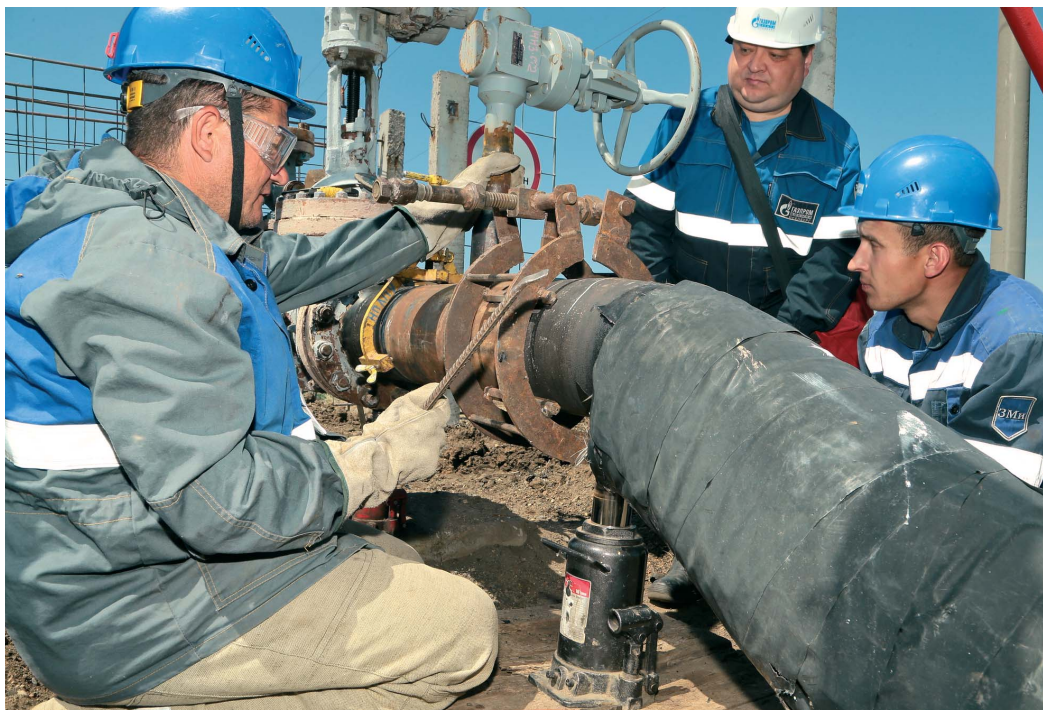
Газорезчик Сергей Филончиков, начальник СТОЗАиМО Сергей Степанов и монтажник технологических трубопроводов Дмитрий Богатырев делают центровку и подгонку сварной катушки
