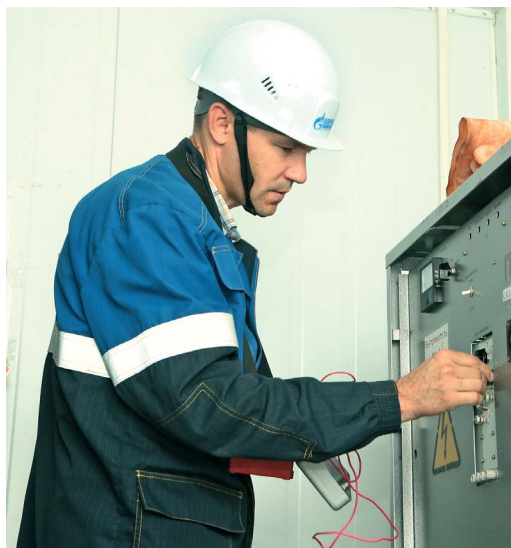
Анатолий Хисматуллин проводит техническое обслуживание оборудования установки электрохимзащиты
