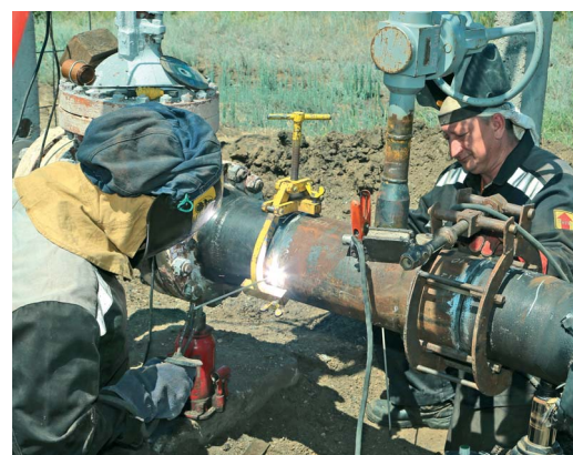
Электрогазосварщики Сергей Швецов и Сергей Щелыкалин выполняют сварное соединение
