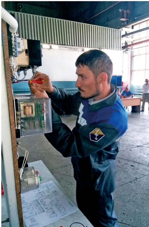
Раавиль Усманов восстанавливает работоспособность схемы автоматического ввода резерва
