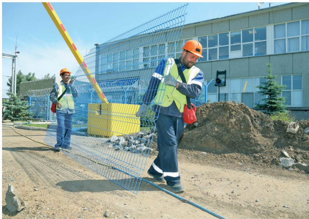
На площадке для досмотра автомобилей устанавливают сетчатое ограждение
