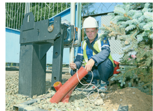
Ведется монтаж системы электропитания противотаранного устройства
