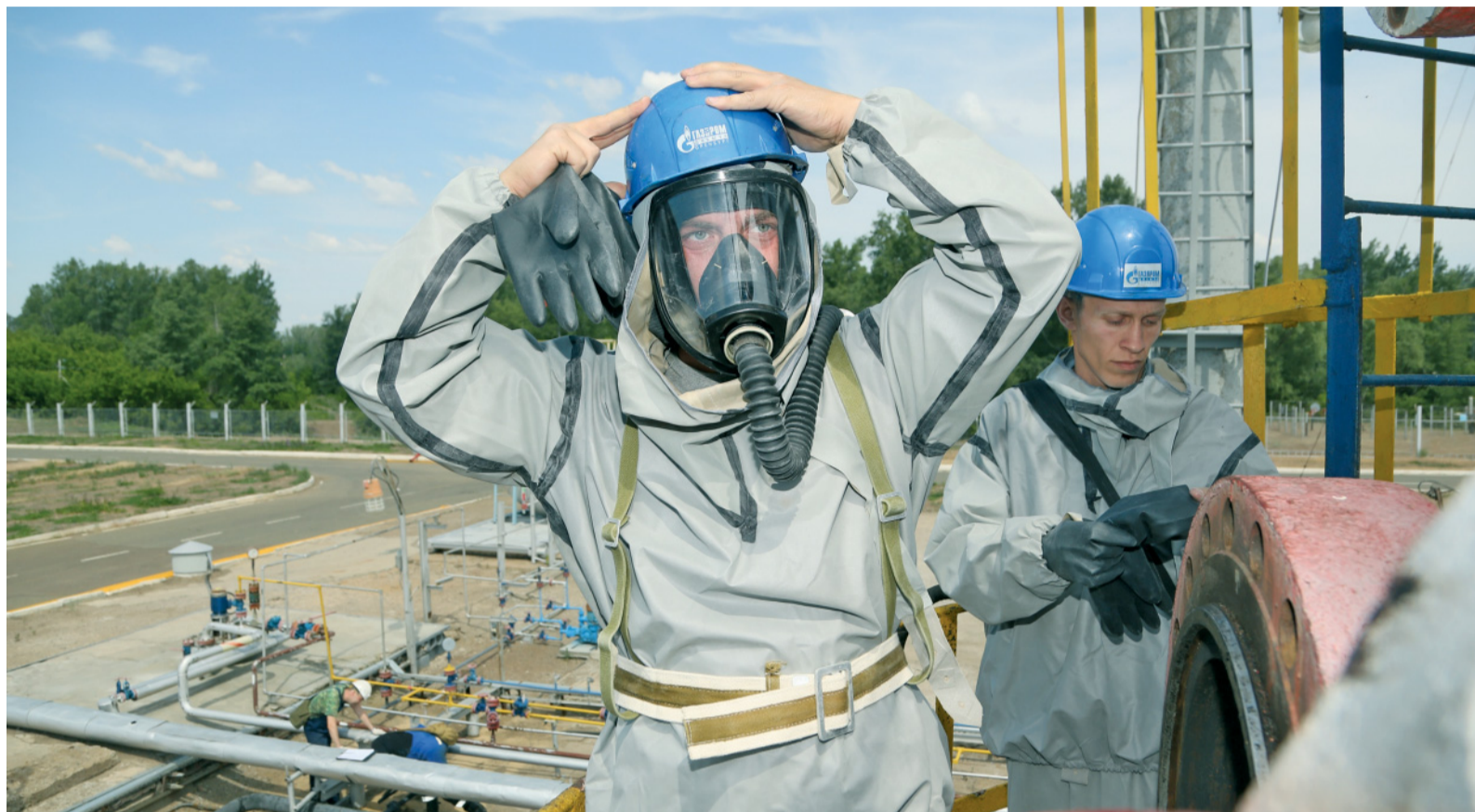
Алексей Дымов (на переднем плане) и Александр Хорьяков готовятся к работе внутри сепаратора
