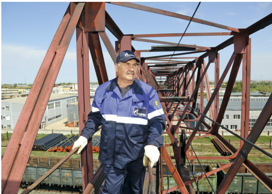
Крановщик Николай Колеганов проводит осмотр консоли козлового крана на высоте 25 метров
