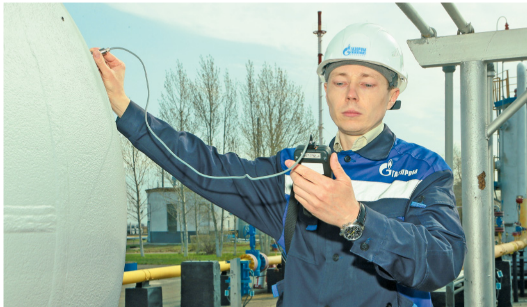
Виталий Иванищев проверяет качество нанесения антикоррозионного покрытия на сепараторе
