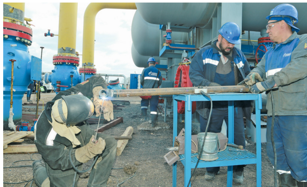
Сварщик Константин Ходарев, машинист Ашот Сафарьян и слесарь Александр Бахтин выполняют сборку заготовки для монтажа трубопровода сброса газа на факел
