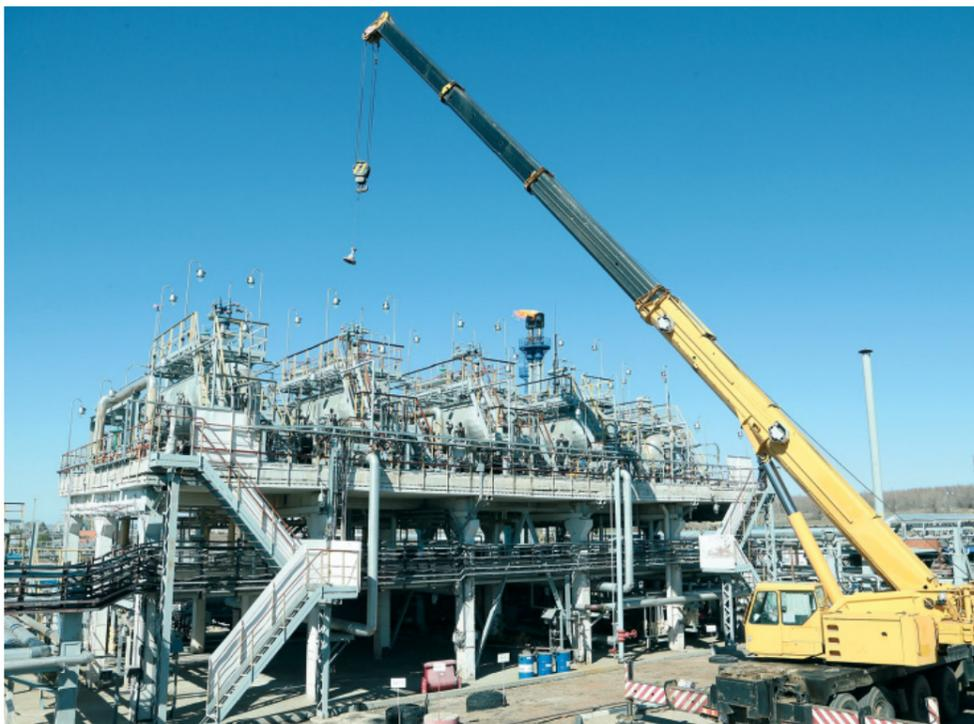
Автокран устанавливает фланцевый переходник на емкость для монтажа предохранительного клапана
