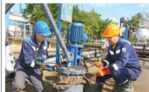
Ведется подготовка к демонтажу погружного насоса дренажной емкости
