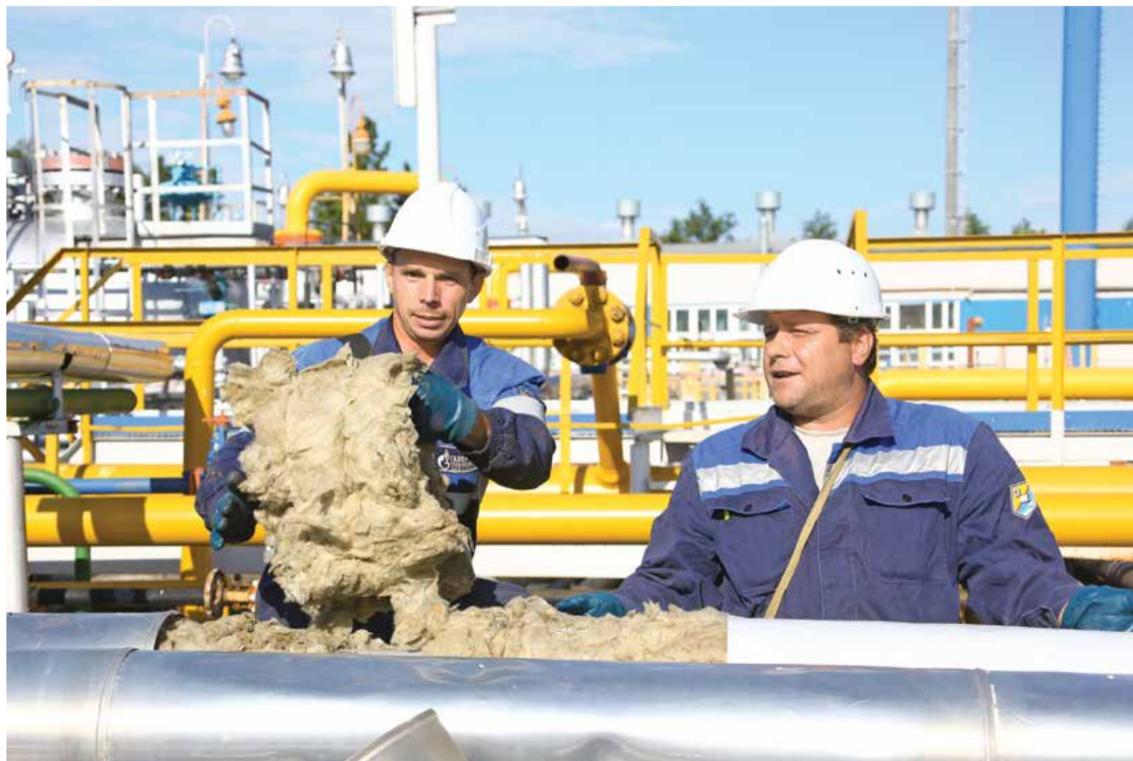
Операторы по добыче нефти и газа ОПС-9 Александр Самодуров и Сергей Межуев выполняют теплоизоляцию трубопровода
