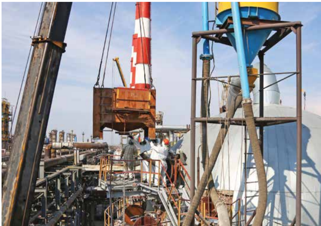
Контейнер, наполненный катализатором, поднять к горловине реактора можно только с помощью подъемного крана
